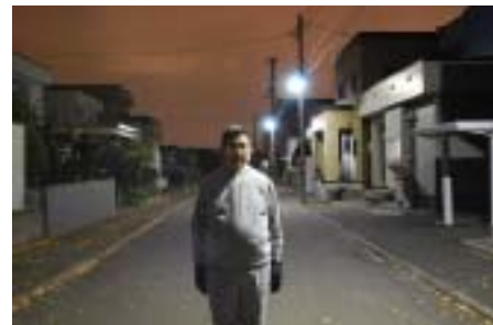
写真 6-2 LED 街路灯 (街路灯管理№：6-1)
